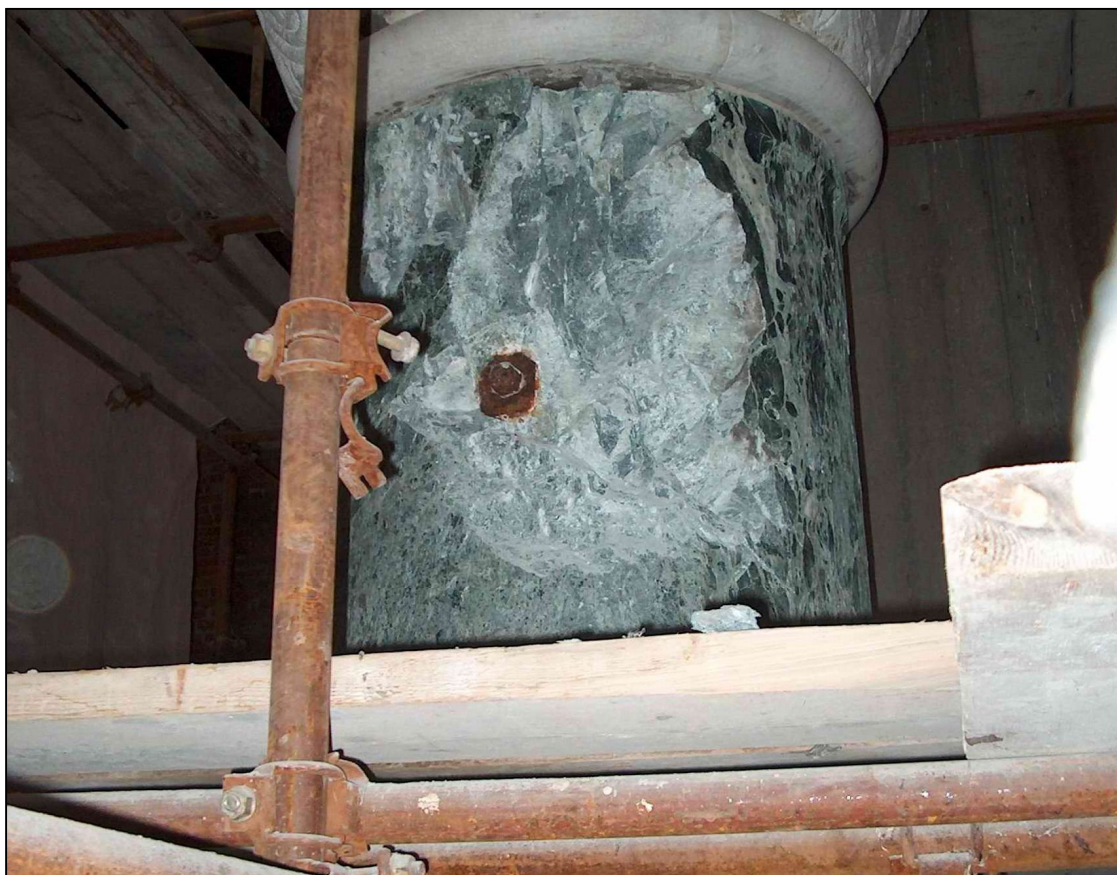
Београд, Храм Светог Саве: оштећења на стубу од мермера „Alpi Verde” настала услед кородирања гвозденог анкера
