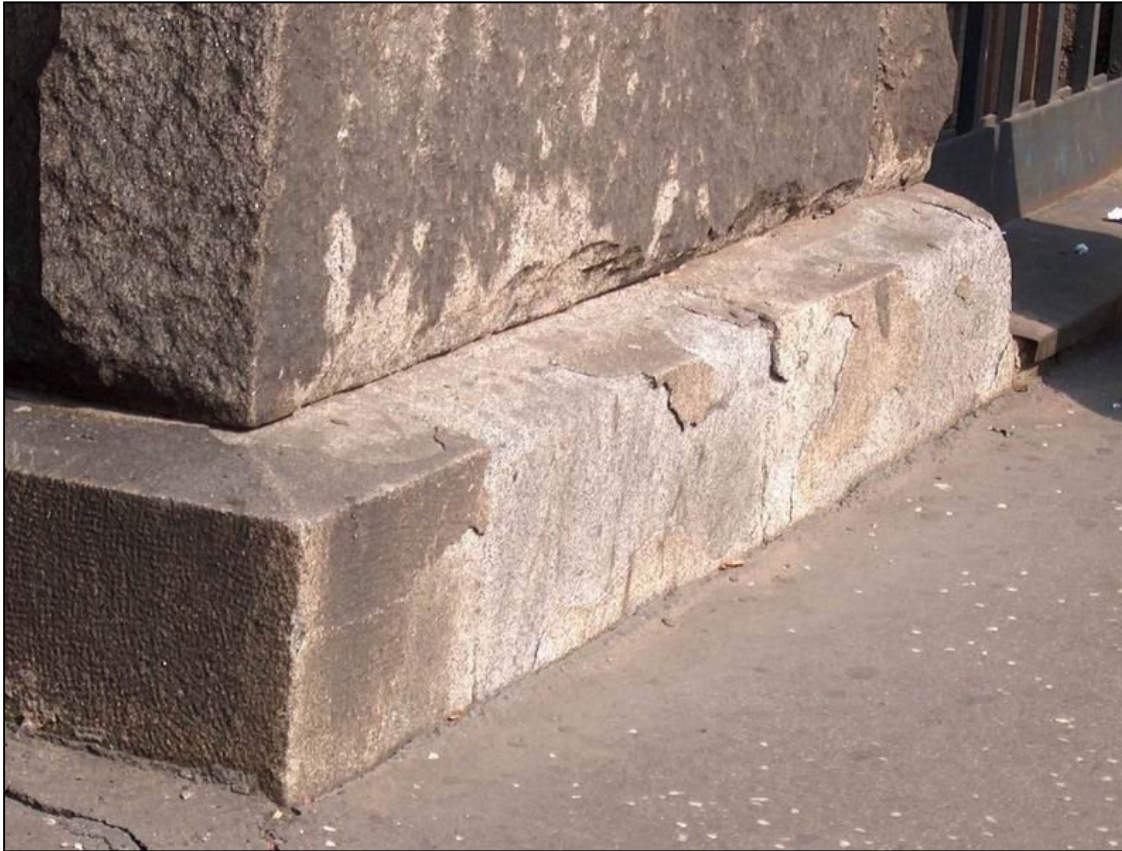
Београд, зграда Главне поште, јужна фасада: оштећења на граниту настала дејством соли
