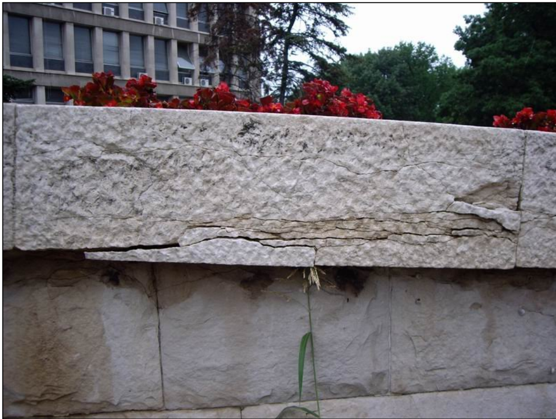
Нови Београд, зграда бившег СИВ-а: оштећења на Брачком мермеру
