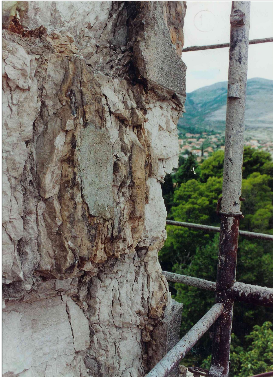
Требиње, Храм Светог Преображења Господњег: оштећења на кречњаку
