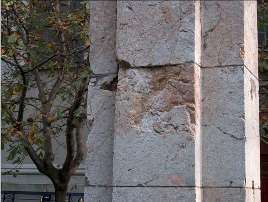
Београд, Храм Светог Архангела Михаила: оштећења на бречи настала испирањем везива (глине)
